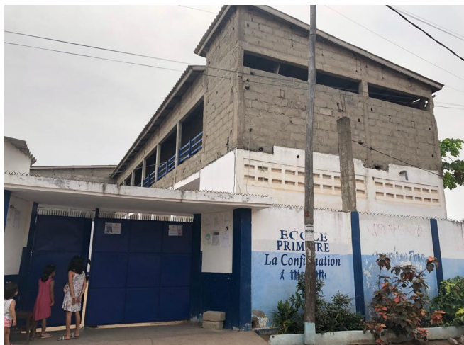
Figure 1 Prima dei lavori (2020)
