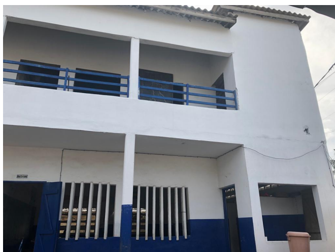
Figure 3 Esterno scuola dopo i lavori (2021)
