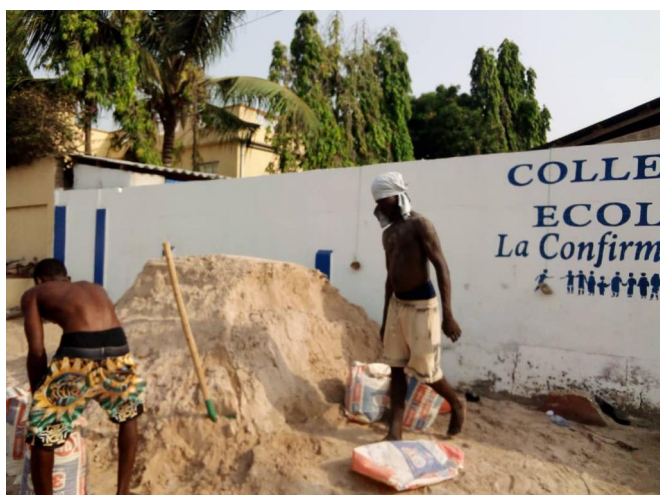
Figure 2 Lavori intonaco esterno (2021)
